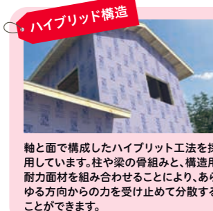
ハイブリッド構造 軸と面で構成したハイブリッド工法を採用しています。柱や梁の骨組みと、構造用耐力面材を組み合わせることにより、あらゆる方向からの力を受け止めて分散することができます。
