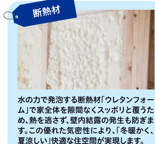
断熱材 水のかたまりで発泡する断熱材「ウレタンフォーム」で家全体を隙間なくスッポリと覆うため、熱を逃さず、壁内結露の発生も防ぎます。この優れた気密性により、「冬暖かく、夏涼しい」快適な住空間が実現します。
