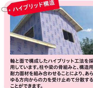
ハイブリッド構造 軸と面で構成したハイブリッド工法を採用しています。柱や梁の骨組みと、構造用耐力面材を組み合わせることにより、あらゆる方向からの力を受け止めて分散することができます。
