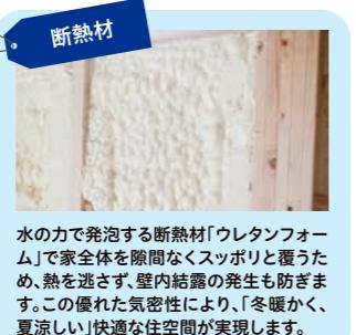
水の力で発泡する断熱材「ウレタンフォーム」で家全体を隙間なくスッポリと覆うため、熱を逃さず、壁内結露の発生も防ぎます。この優れた気密性により、「冬暖かく、夏涼しい」快適な住空間が実現します。
