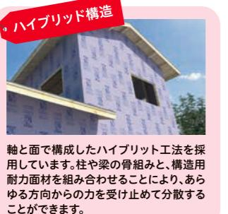
軸と面で構成したハイブリット工法を採用しています。柱や梁の骨組みと、構造用耐力板材を組み合わせることにより、あらゆる方向からの力を受け止めて分散することができます。
