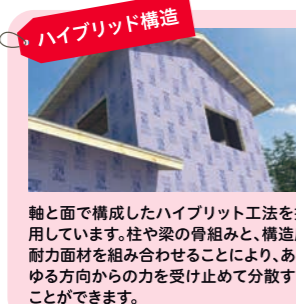
ハイブリッド構造 軸と面で構成したハイブリッド工法を採用しています。柱や梁の骨組みと、構造用耐力面材を組み合わせることにより、あらゆる方向からの力を受け止めて分散することができます。
